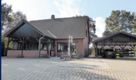
Twist, Einfamilienhaus mit Nebengebäuden
